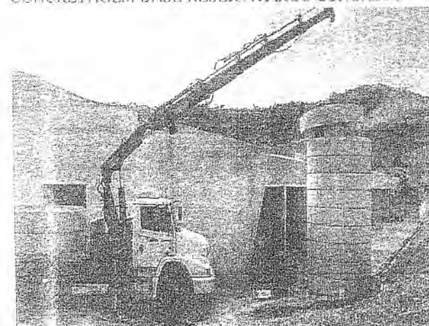
MONTELAGEM RESERVATORIO ANEIS DE CONCRETO
