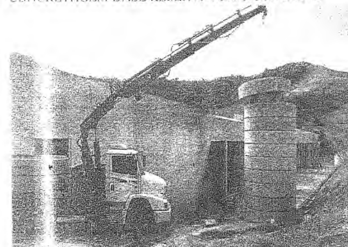
MON. AÇIEM RESERVATORIO ANEIS DE CONCRETO
