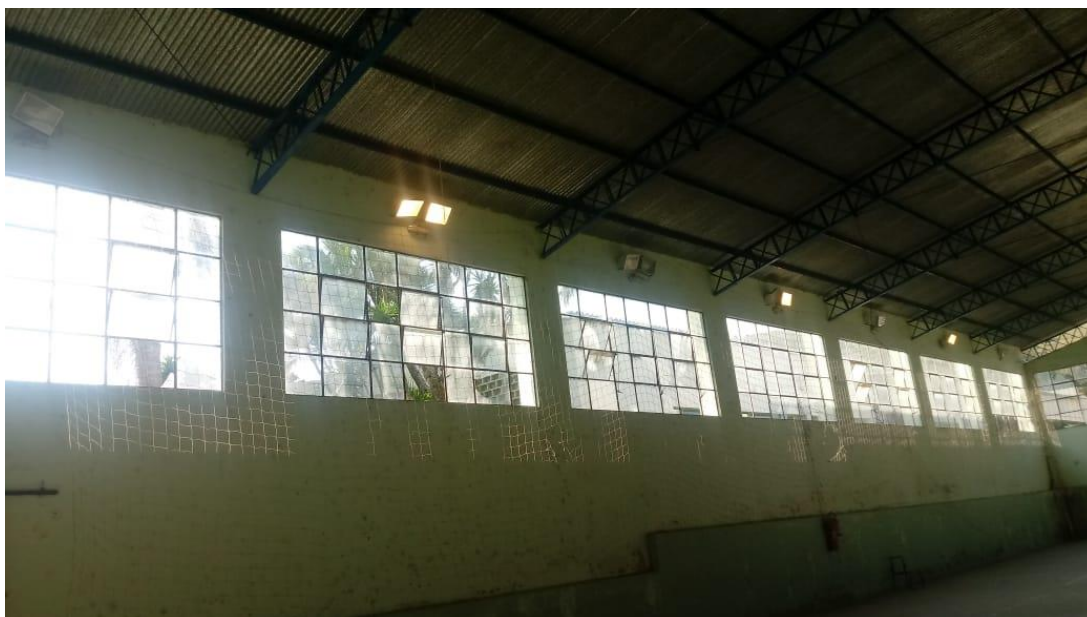
Foto 11: trocas de luminárias
