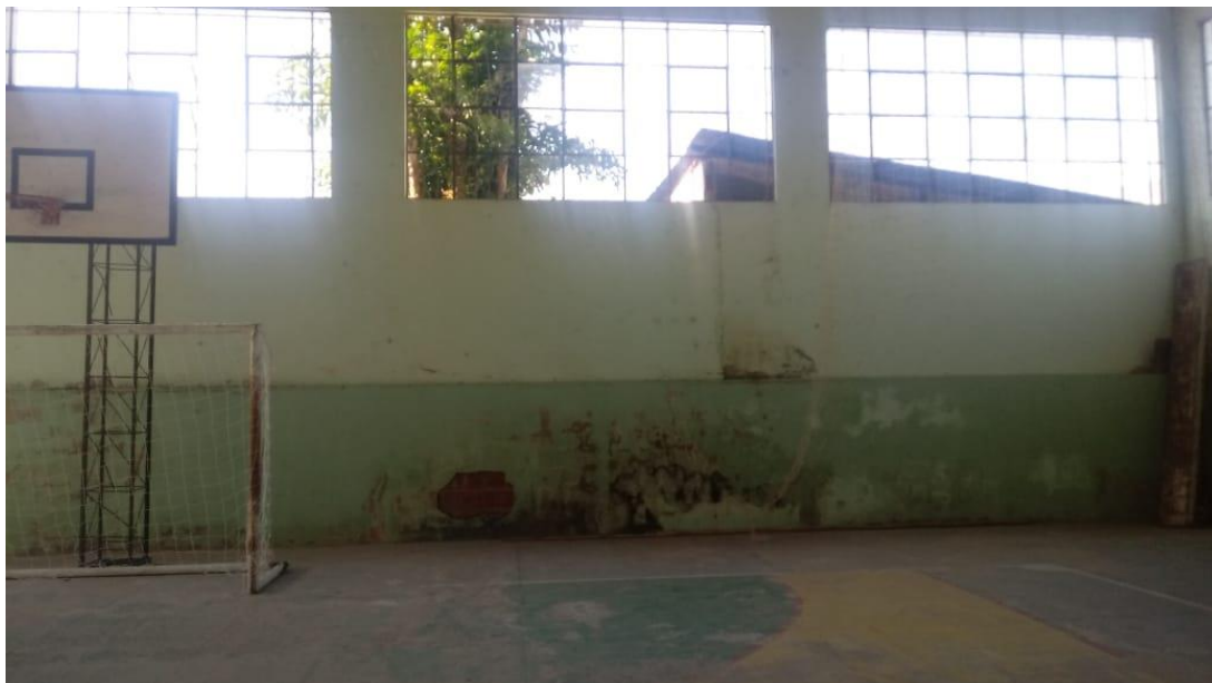
Foto 05: Regularização de parede e tratamento impermeabilizante da parte externa.
