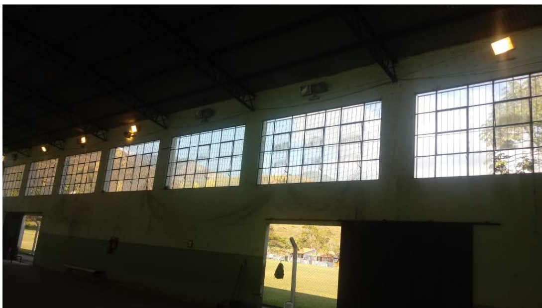
Foto 10: trocas de luminárias
