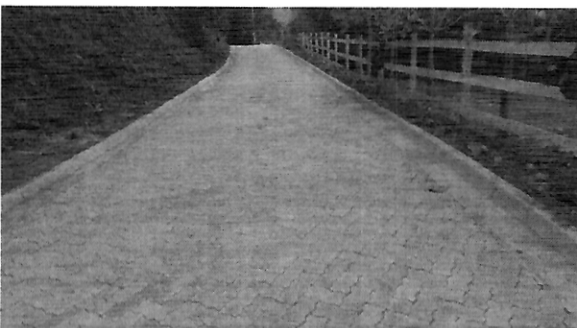
BASE E PAVIMENTAÇÃO
