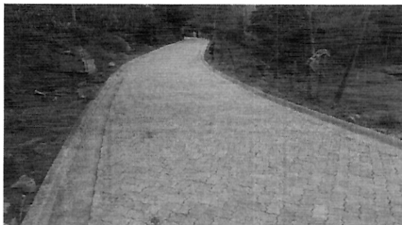
BASE E PAVIMENTAÇÃO
