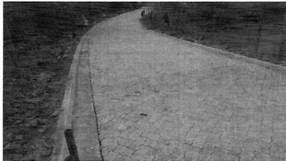
BASE E PAVIMENTAÇÃO
