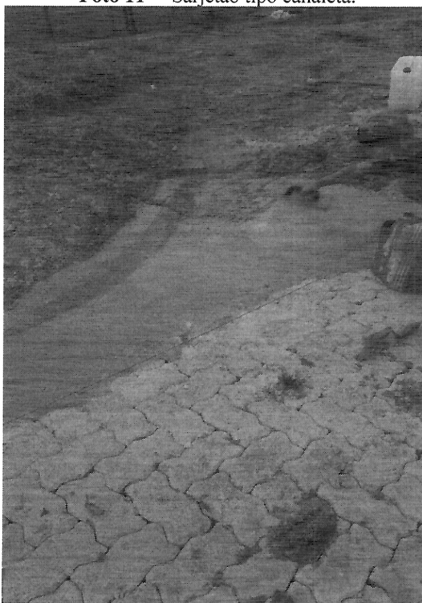
Foto 11 – Sarjetão tipo canaleta.
