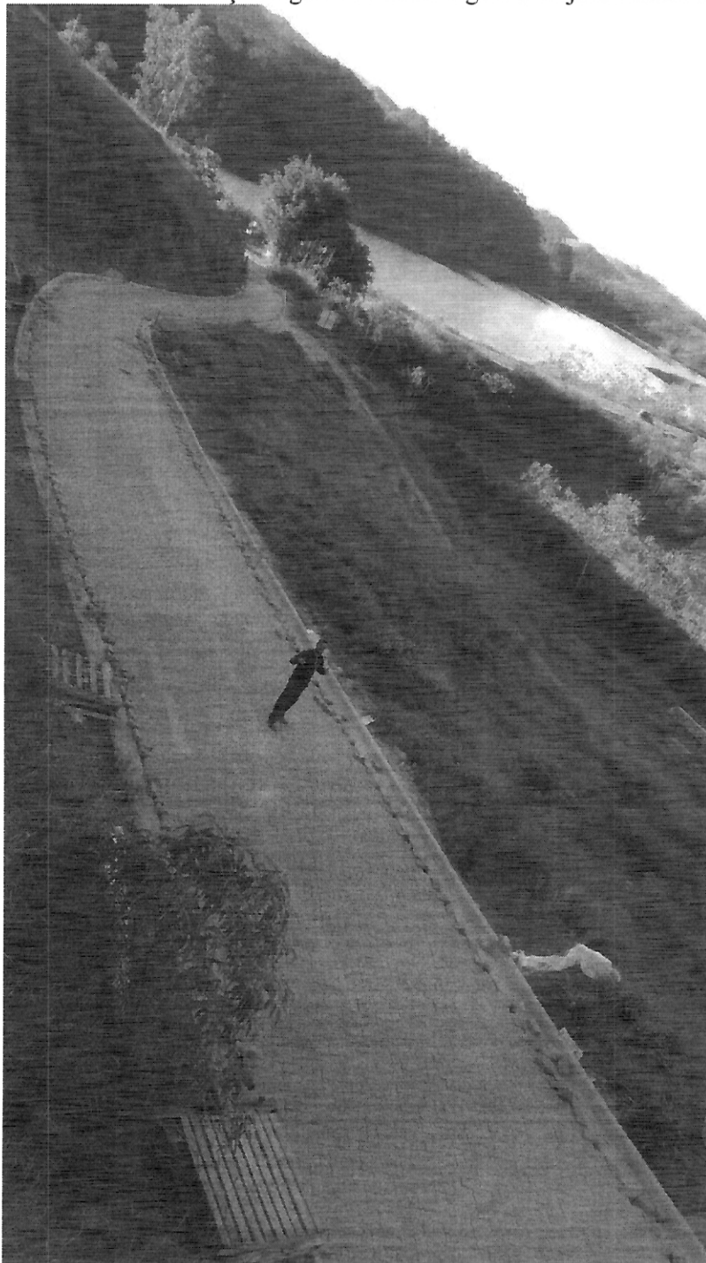
Estrada Municipal Julieta Cantelmo - SJO-149 - Trecho II
