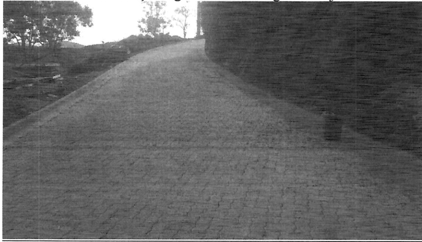
Foto 03 – Pavimentação e guia enterrada e guia e sarjeta extrusada.
