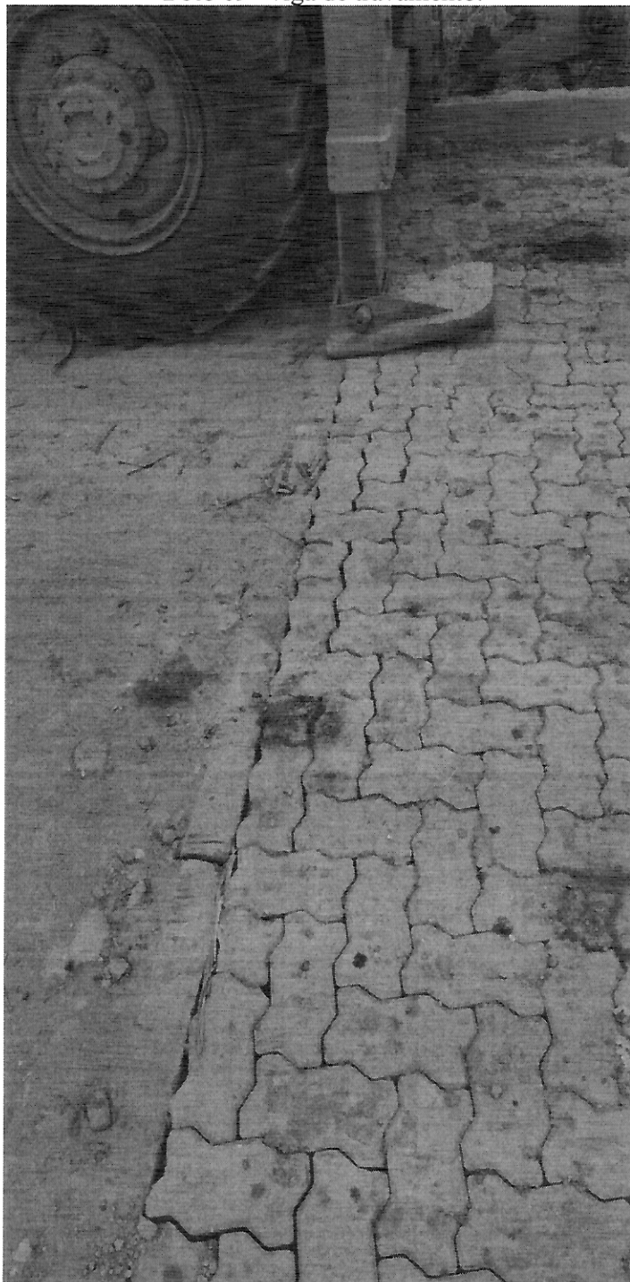
Foto 09 –viga de travamento.
