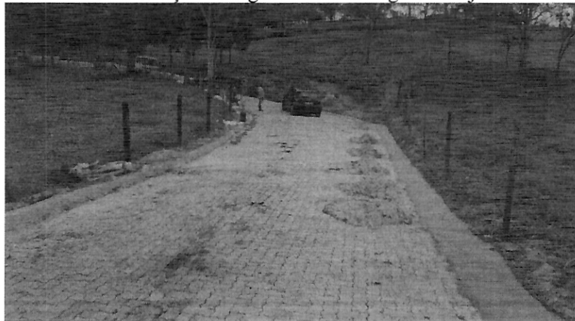
Foto 08 – Pavimentação com guia enterrada e guia e sarjeta extrusada.
