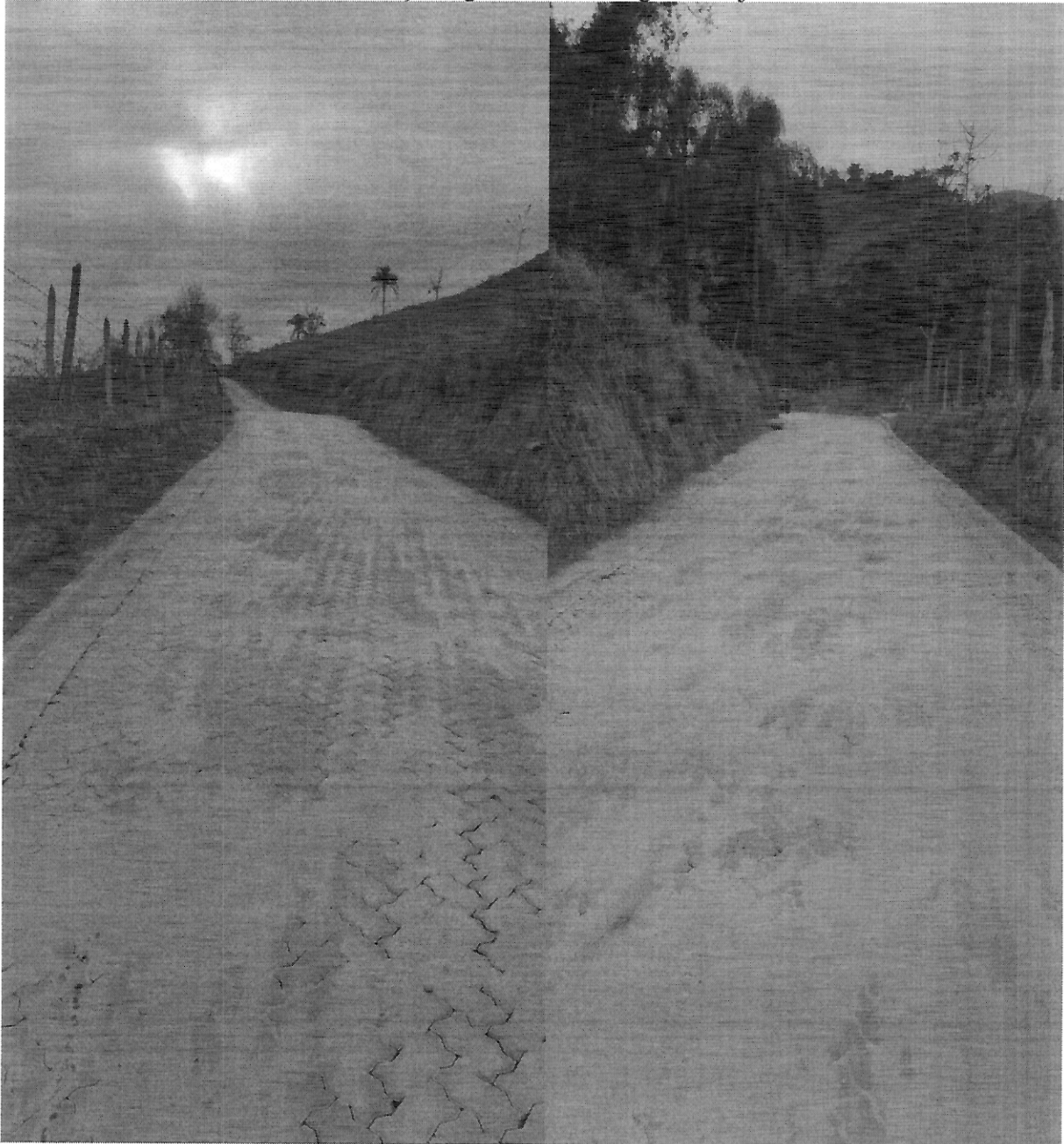
Foto 05 – Pavimentação e guia enterrada e guia e sarjeta extrusada.
