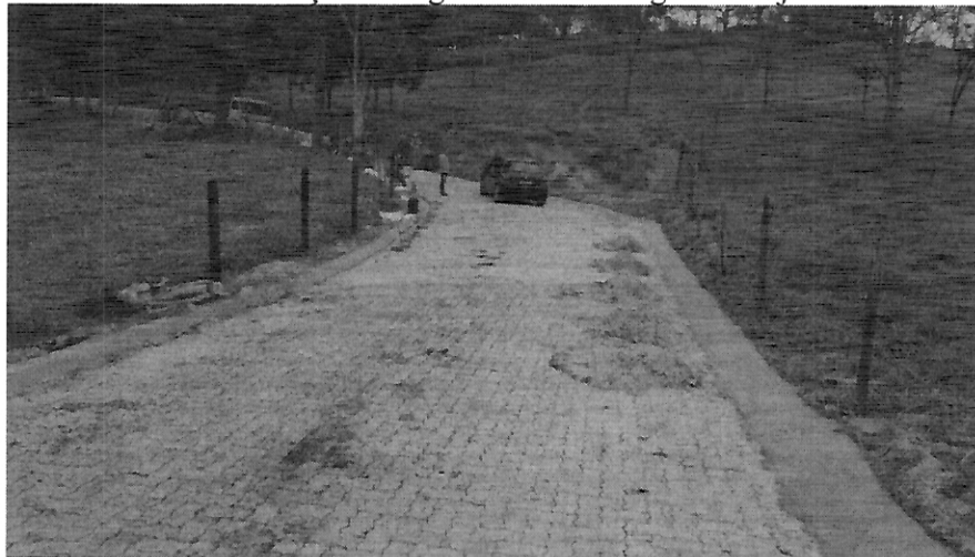
Foto 10 – Pavimentação com guia enterrada e guia e sarjeta extrusada.
