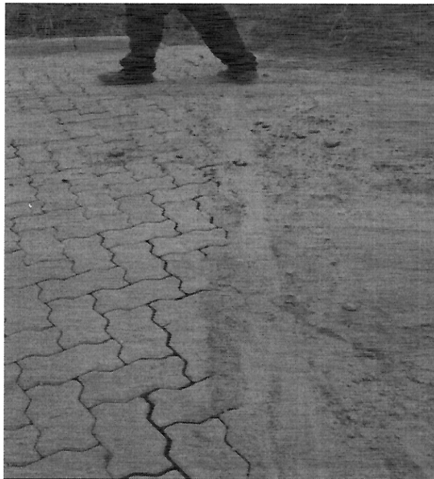
Foto 04 – Viga de Travamento.
