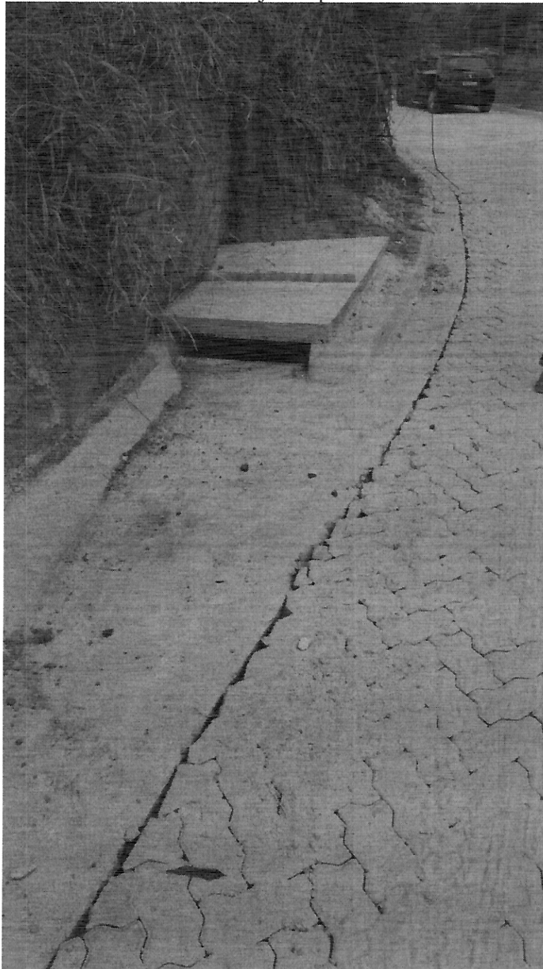
Foto 06 – Sarjetão tipo canaleta
