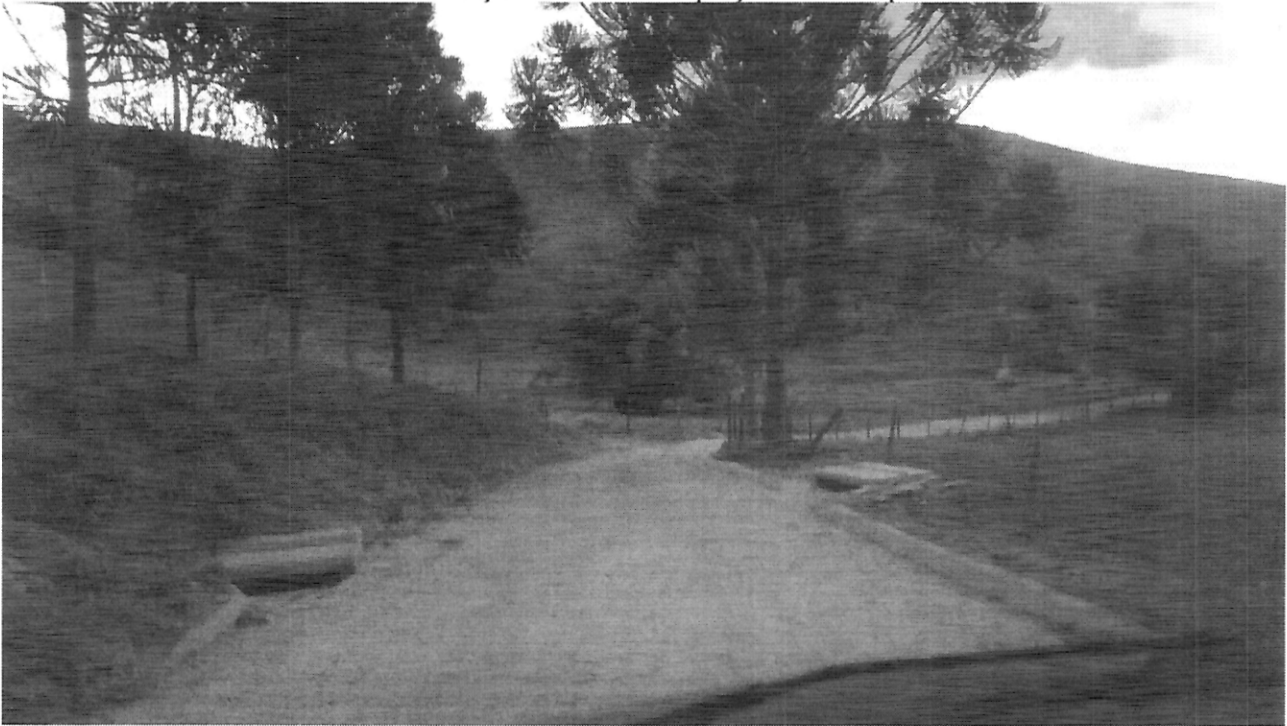
Foto 12 – Pavimentação e caixas de captação com tampa de concreto.
