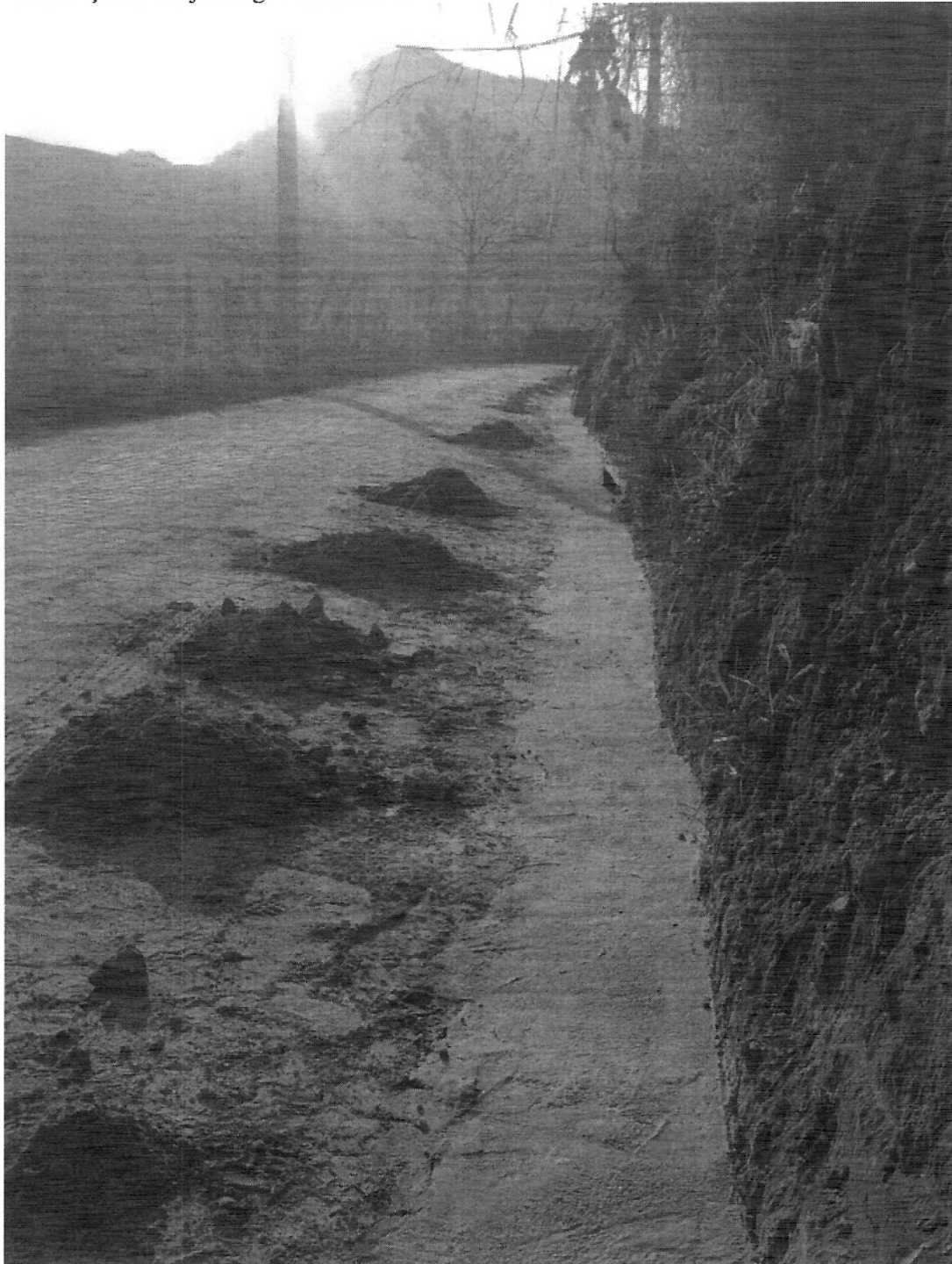
Foto 03 – Construção de sarjeta e guia enterrada.
