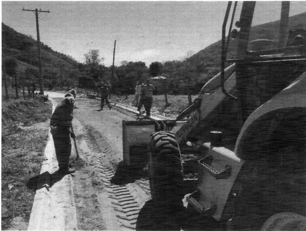
Foto 04 – Estrada da Barra – Colocação do material.
