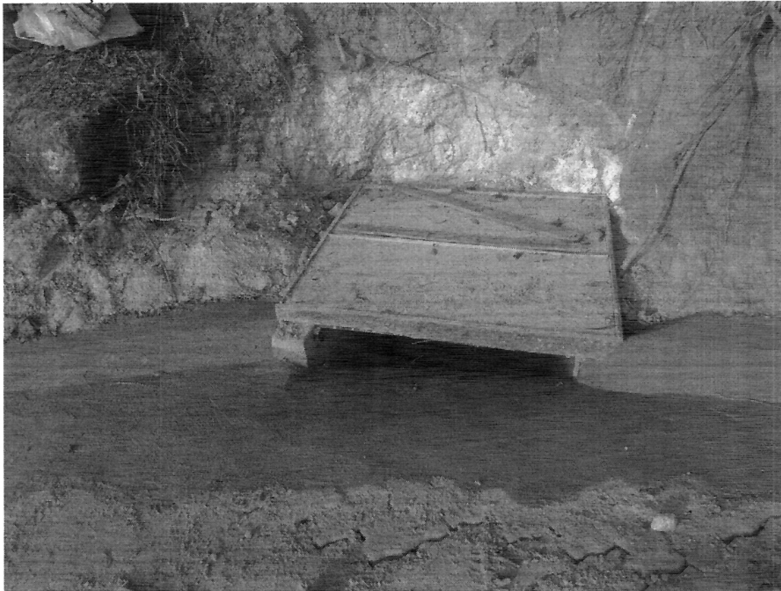
Foto 06 – Rejuntamento com areia.
