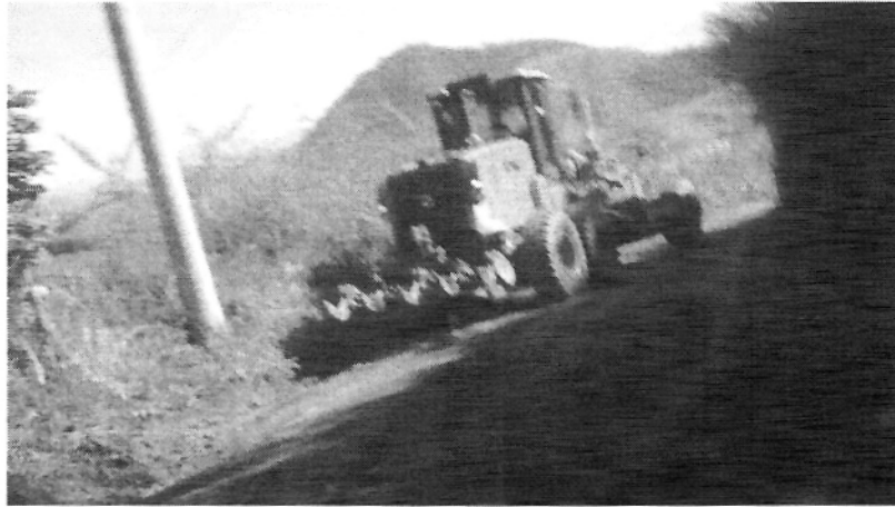
Foto 01 – Estrada do Monjolinho – Movimento de terra.
