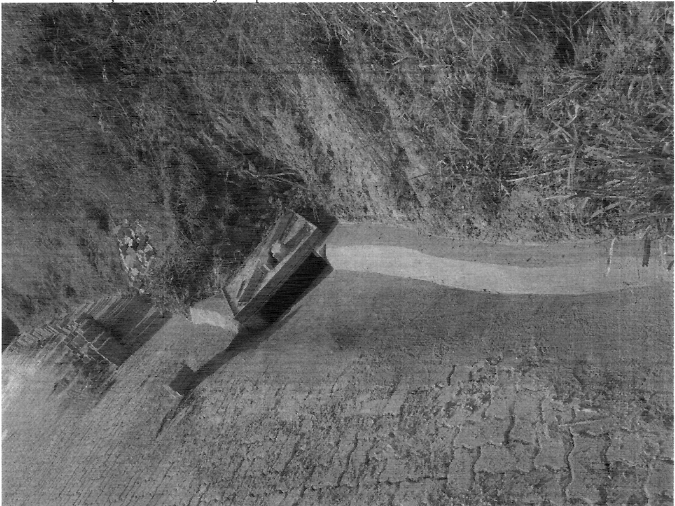
Foto 01 – Construção de caixa e sarjetão tipo canaleta.
