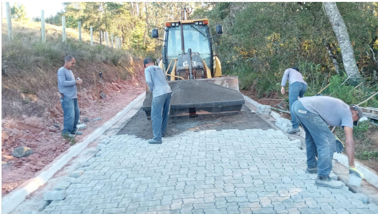
Imagem 6: Exemplo de asfaltagem com bloco de concreto intertravados sendo realizada em estradas turísticas de São José do Barreiro.
